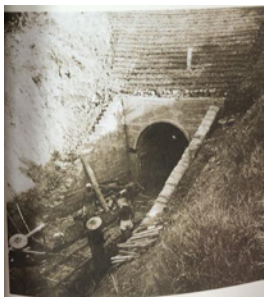
图19 兴建中的北沟防空洞 ②
